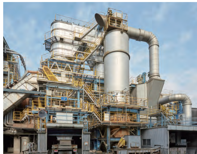
ロータリーキルン&ストーカ炉 能力：72t/日、熱回収あり
